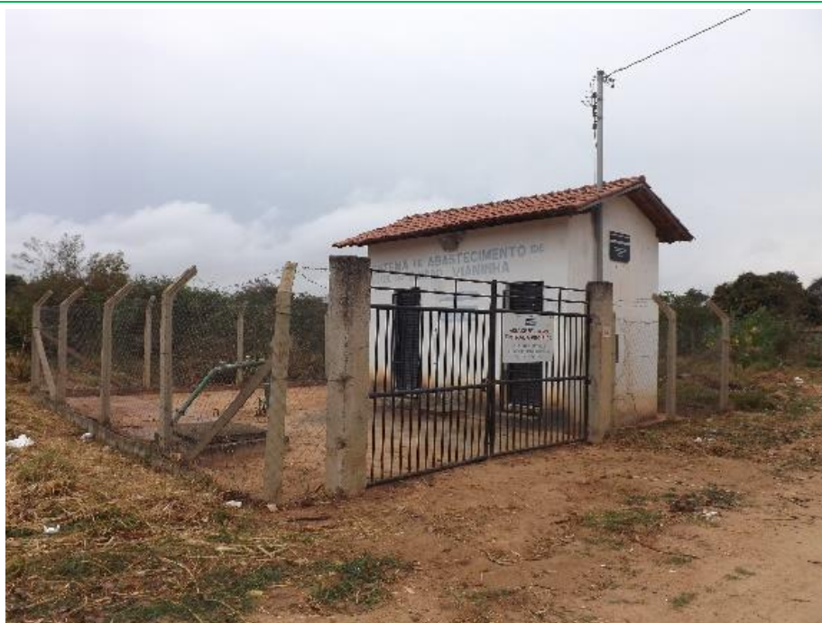
Figura 8.5 – Captação de água da COPASA na localidade.
